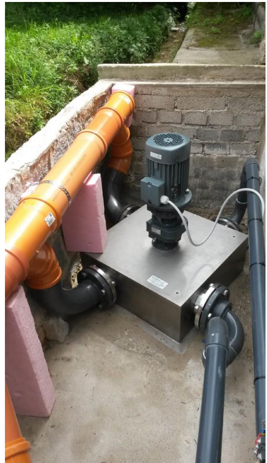
Turbine mit Getriebe, Generator und Kunststoffverrohrung
